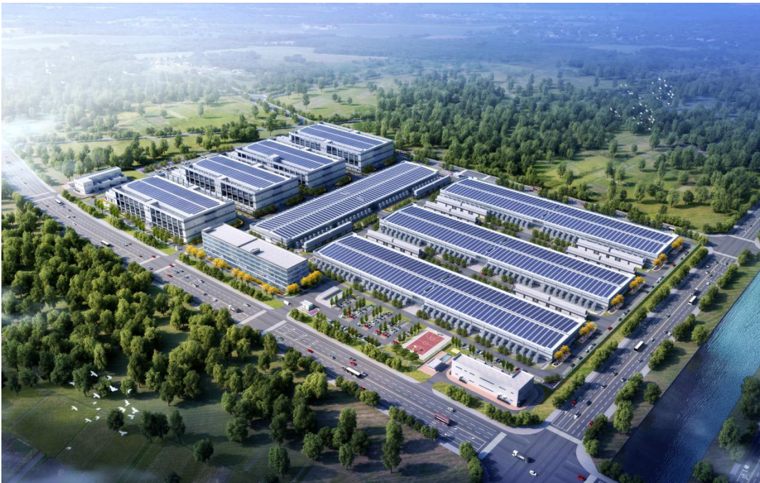
天津高新云数据中心项目
